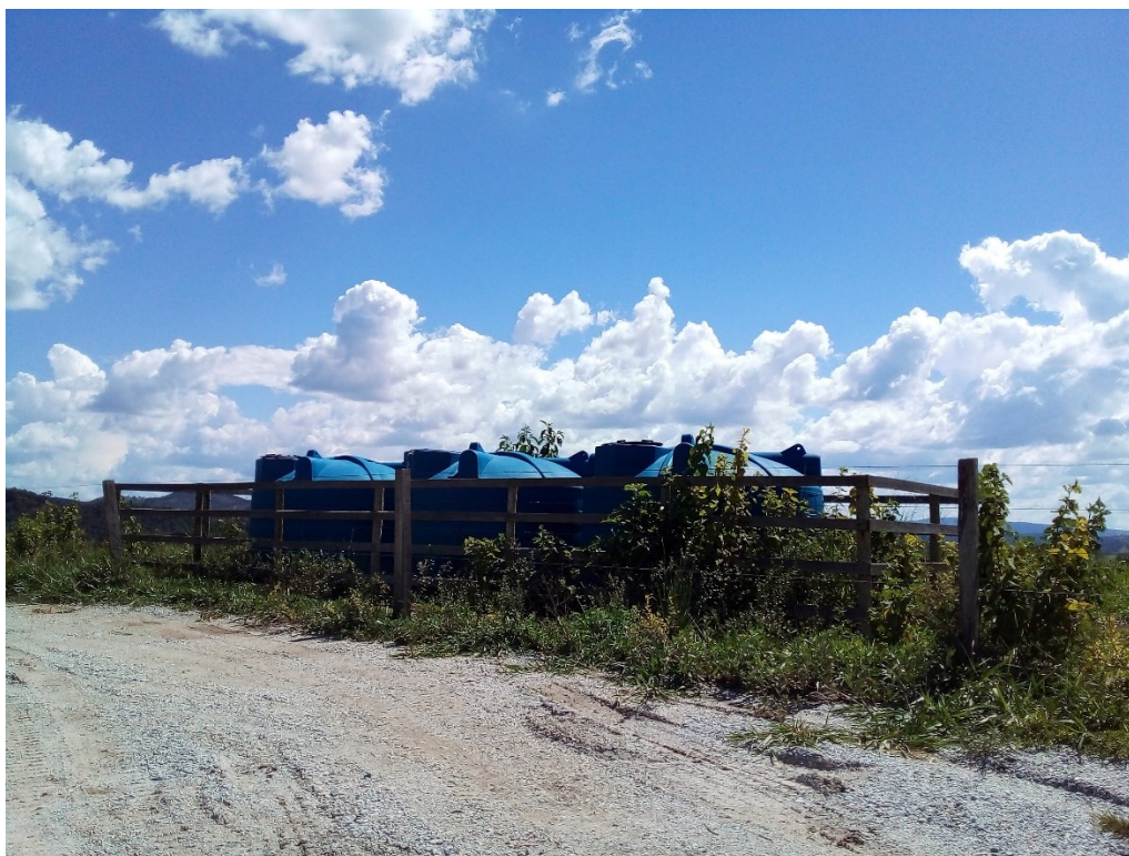
Figura 13: Fotografias de instalações atingidas pela inundação do rio Paraopeba no início do ano de 2020 na comunidade de Três Barras, em Fortuna de Minas, MG.
