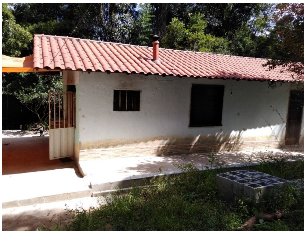
Figura 18: Altura da coluna de água em uma das edificações atingidas pelas cheias do rio Paraopeba nas comunidades visitadas em Vista Alegre, Esmeraldas.
