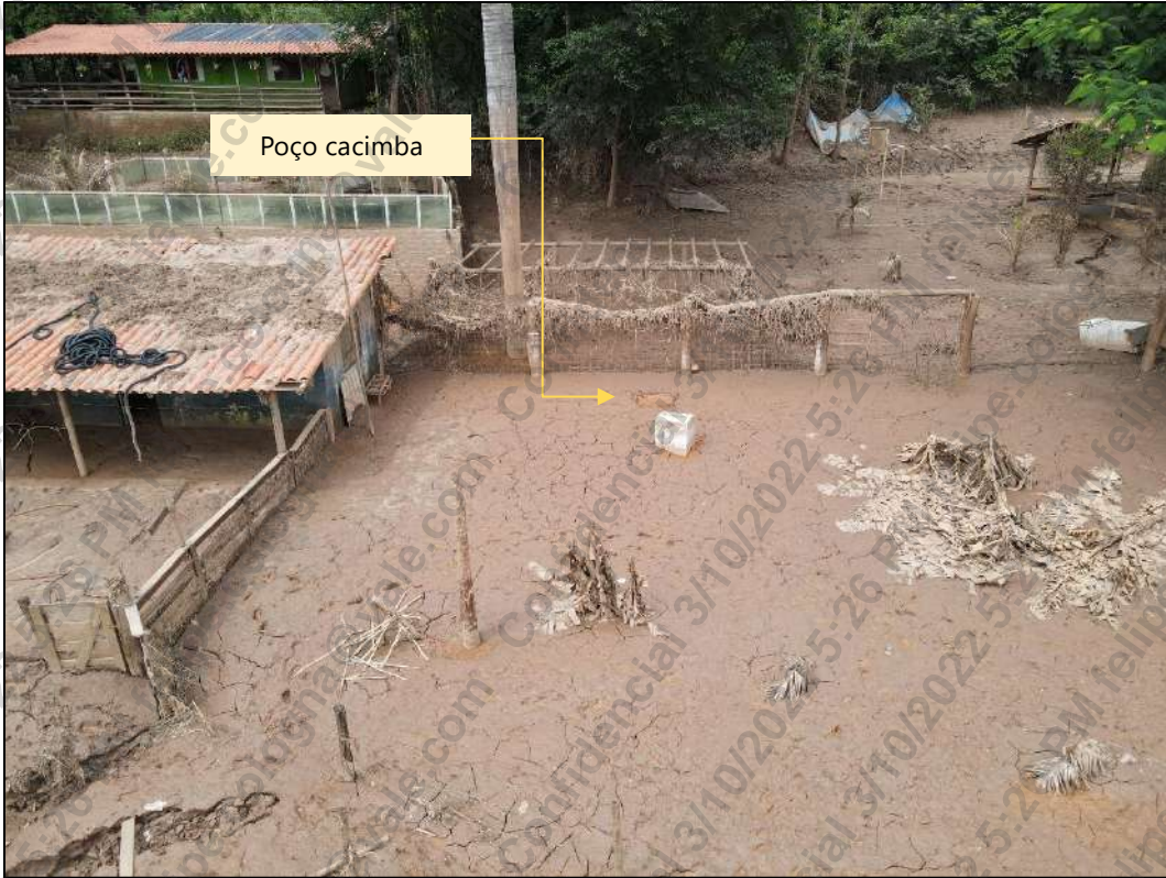
Foto 2 – Registro na comunidade de Taquaras evidenciando poço cacimba soterrado pelos sedimentos carregados pela inundação (02/02/2022).
