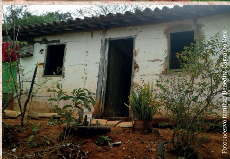
Acima, casas feitas em pau-a-pique por pessoas atingidas, em Passa Sete. Abaixo, em Teodoro / Água Quente.
