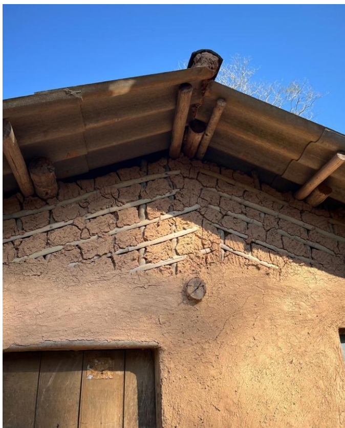
Figura 7: Registro fotográfico casa construída em pau a pique, Passa Sete.
