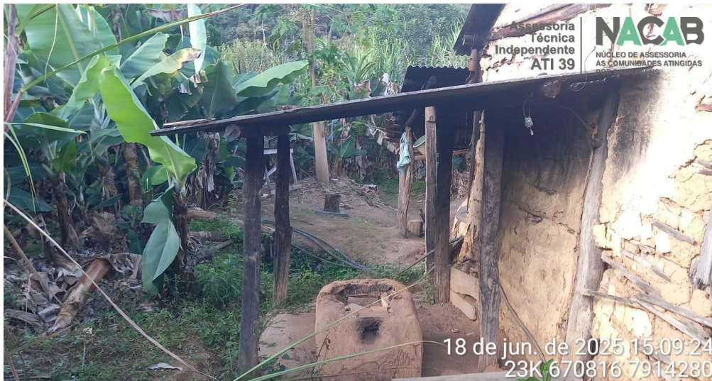
Figura 6: Registro fotográfico de casa construída em pau a pique, Passa Sete.
