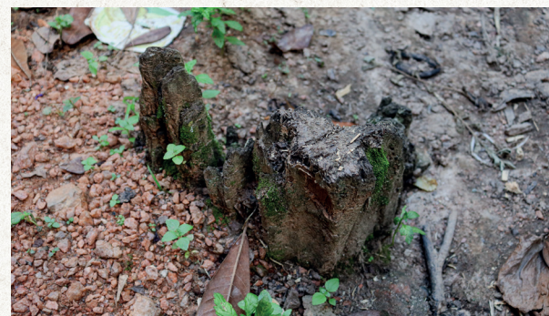
■ Abaixo, esteio em madeira e escada de pedra, na casa de Dona Sussuca
