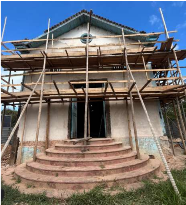
Capela de São Sebastião em restauro; à direita, vista interna da obra
