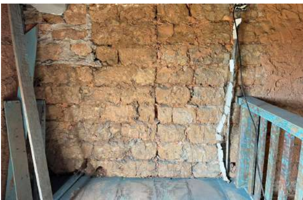
Parede com tijolos de adobe originais
